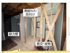
台風・地震など揺れに強い耐力壁 筋交も入れ耐震性アップ!
