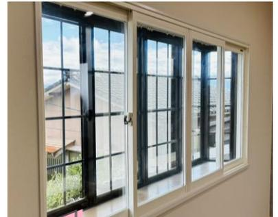
すべての出窓に内窓を取付け断熱性はもちろん、防音効果・防犯対策もバッチリ！
