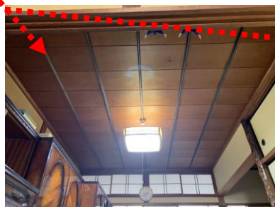
【天井】筭縁天井
