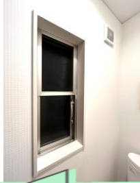
1階 トイレ 縦すべり出し窓
