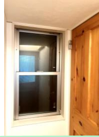
1階 トイレ前 上げ下げ窓
