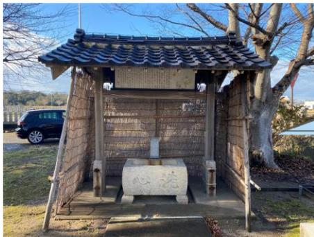
神社を管理している立野石材さまから修繕のご依頼がありました。手水舎の屋根を支えている柱が長年の雨風の影響で腐朽化し、いつ倒れてもおかしくない状態でした。
