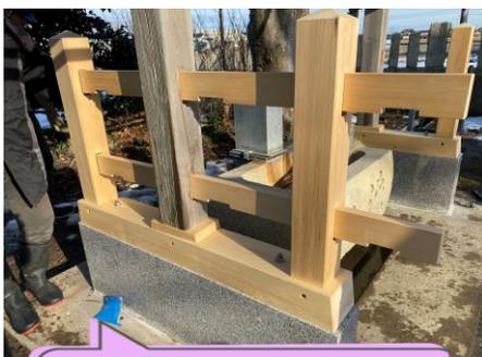
新しい柱は、耐久性に配慮し、青森県のヒバ材を使用。元の柱とヒバの柱を釘を使わない「ほぞ継ぎ」加工し、緊結しました。
