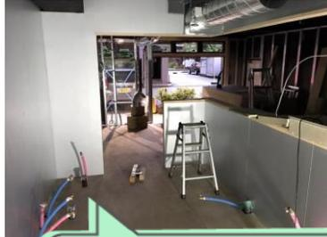
うどんを茹でる際の大量の湯気をバランスよく厨房から排気できるよう、吸排気の計算をし、設計しました。店内の壁下地には燃えにくい素材を使用しています
