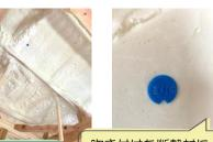
吹き付けた断熱材に ピンを刺して、所定の 厚みが施工されたかを 確認します
