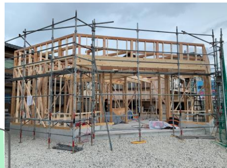
建前（上棟）の様子
