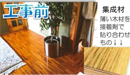
フローリング（集成材）の接着剤が、経年劣化により剥離してきていました
