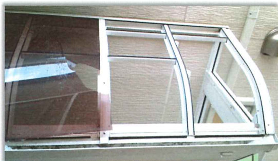
大屋根からの落雪によりサンルームの屋根が割れました
