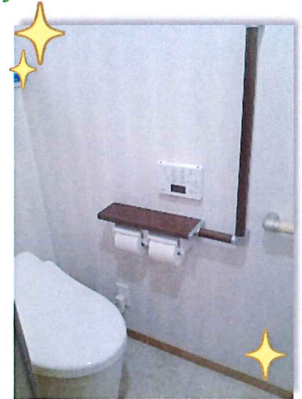
タイルの壁も補強して クロス張りの壁に変更 手すりも取付け温かい快適なトイレに変わりました
