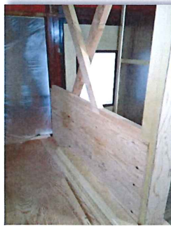
ダブル筋交いを入れ、筋交い金物で補強
